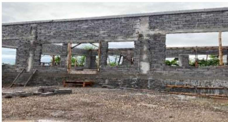
Gambar 1.3 proses pembangunan Musholla
